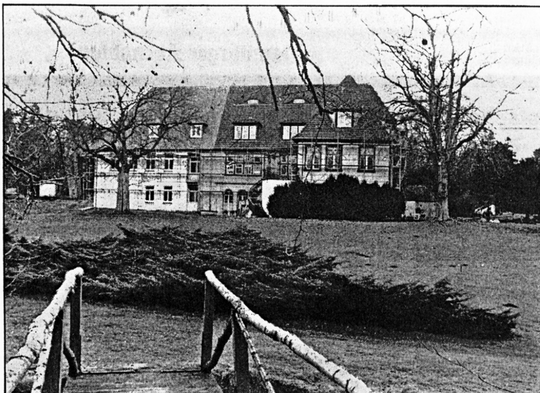
Park-Klinik Manhagen, von der Gartenseite. Links der Anbau, rechts die alte Villa. Foto: MOMSEN
